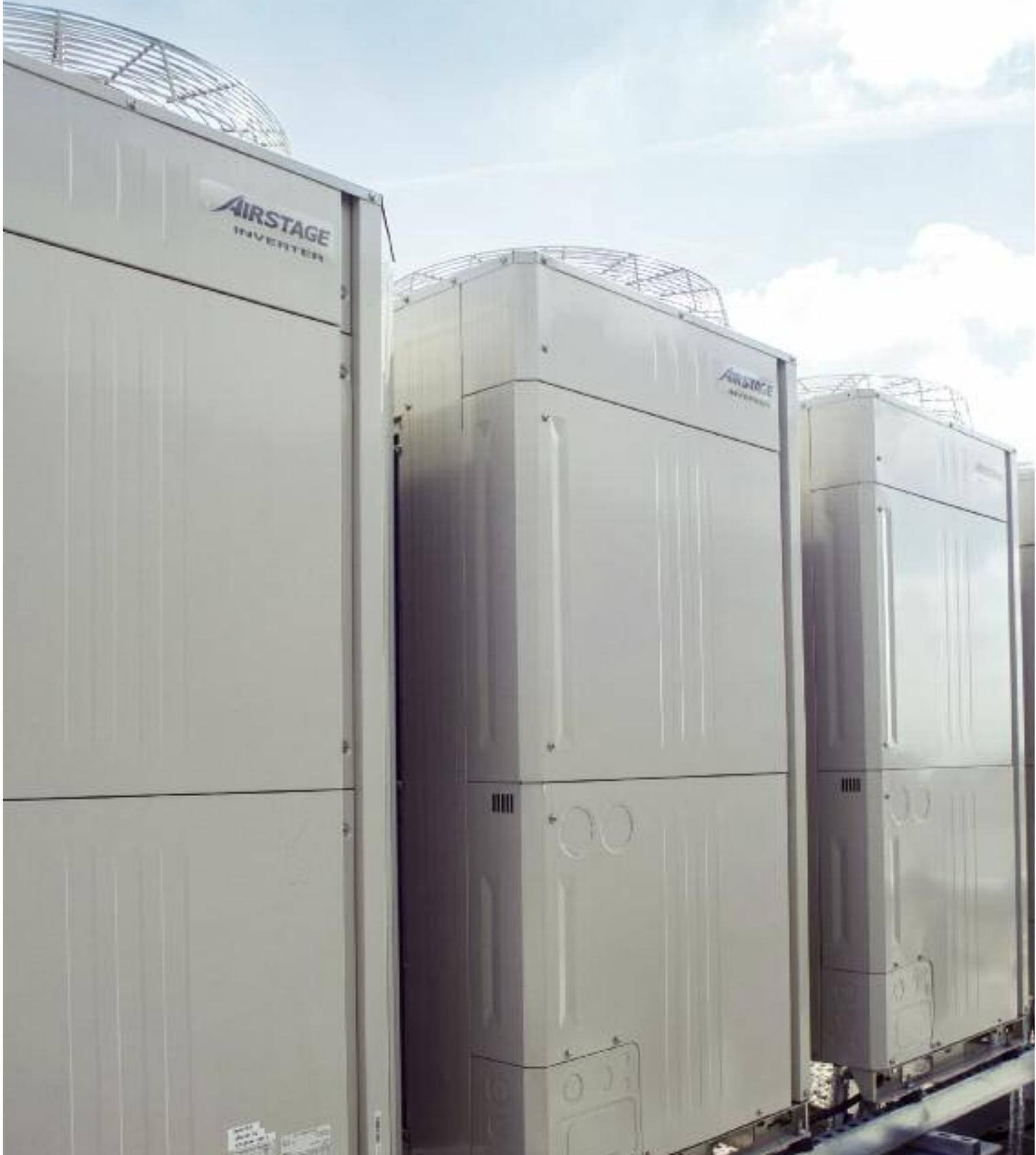
**NEU** Max. **48 HP** Wärmerückgewinnung
